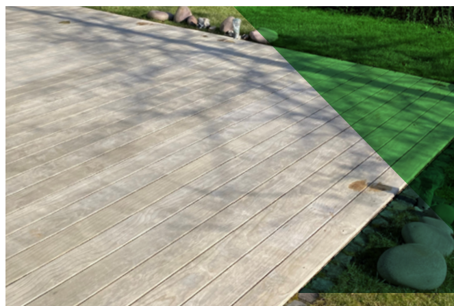
Holzterrasse in Deutschland nach 10 Jahren Vergrauung und regelmäßiger Reinigung
