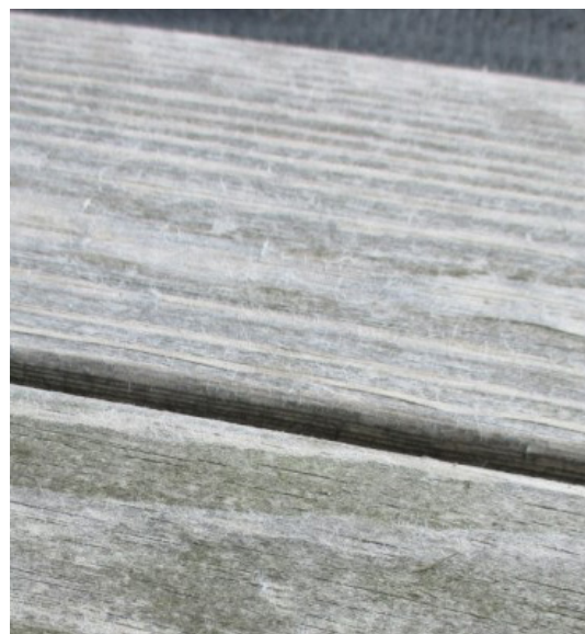
8.4 Natürlich vorkommende Oberflächenfasern auf Bodenbelägen
