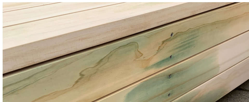
DOCHTWIRKUNG VON CHEMIKALIEN BEI DRUCKBEHANDELTEN WEICHHOLZSPANTENWERK DURCH ACCOYA
