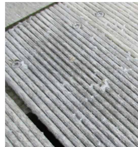
8.4 Les fibres peuvent être piégées dans le profilage de la surface nervurée
