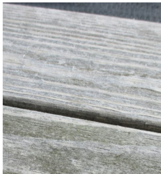
8.4 Fibres de surface naturelles sur les terrasses
