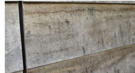
Les surfaces rugueuses sciées sont plus propices à l'accumulation
